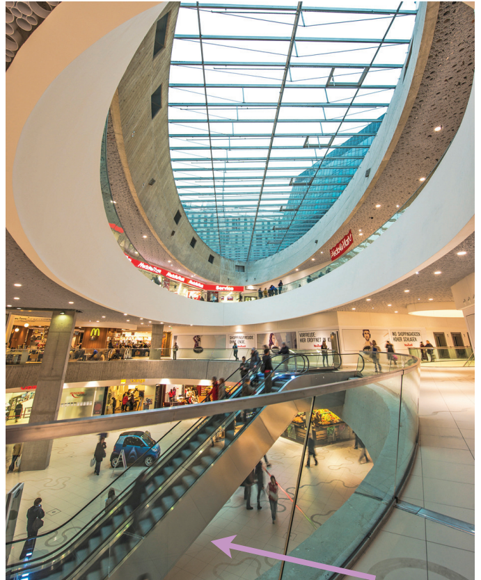
Ungesicherte Gefahrenstelle Rolltreppe: Für Blinde ist die Barriere in Kopfhöhe (siehe Pfeil) nicht erkennbar, das Verletzungsrisiko groß. Photo: Ekazent
